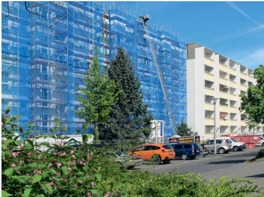
In der Rathener- und Schönaer Straße geht die Modernisierung gut voran.
