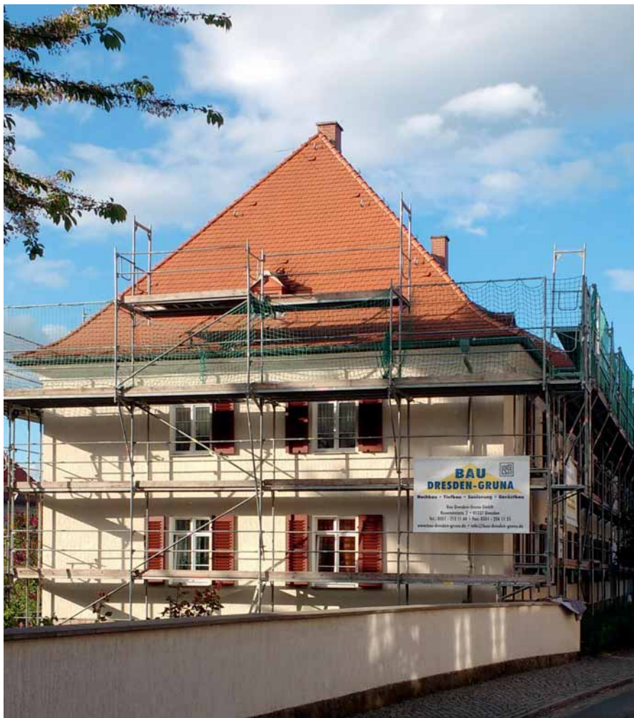
Am Grüngürtel 8–12 wird fleißig an der Modernisierung gearbeitet.
