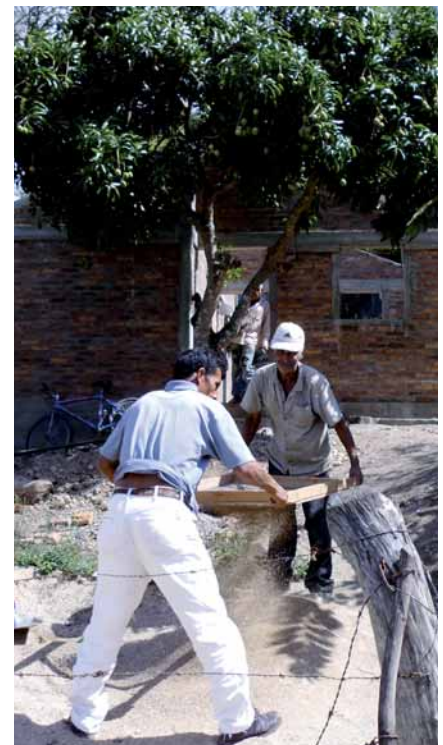
Mit viel Eigenleistung beteiligen sich alle am Bau: Hier in Nicaragua wird Sand gesiebt für die Herstellung von Mörtel.
