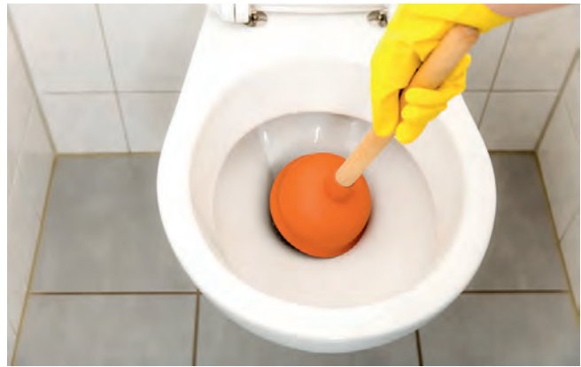
Sollte das WC einmal verstopft sein, hilft der gute alte Pömpel. Die sogenannte Saugglocke beseitigt meist schon nach einigen Pumpvorgängen das Problem. Danach die Spülung betätigen.
