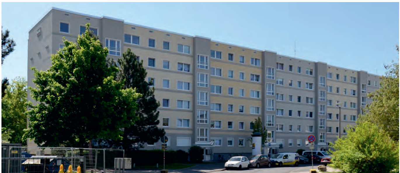
Schon fertig saniert und modernisiert: Die Wohnhäuser Rathener Straße 89–103.
