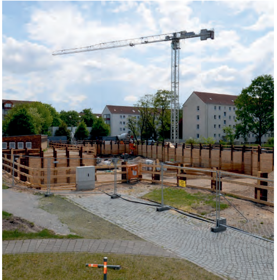
Ohne Probleme und planmäßig: Bauaushub für die Tiefgarage des Neubaus zwischen der Hähnelstraße und der Schumannstraße.
