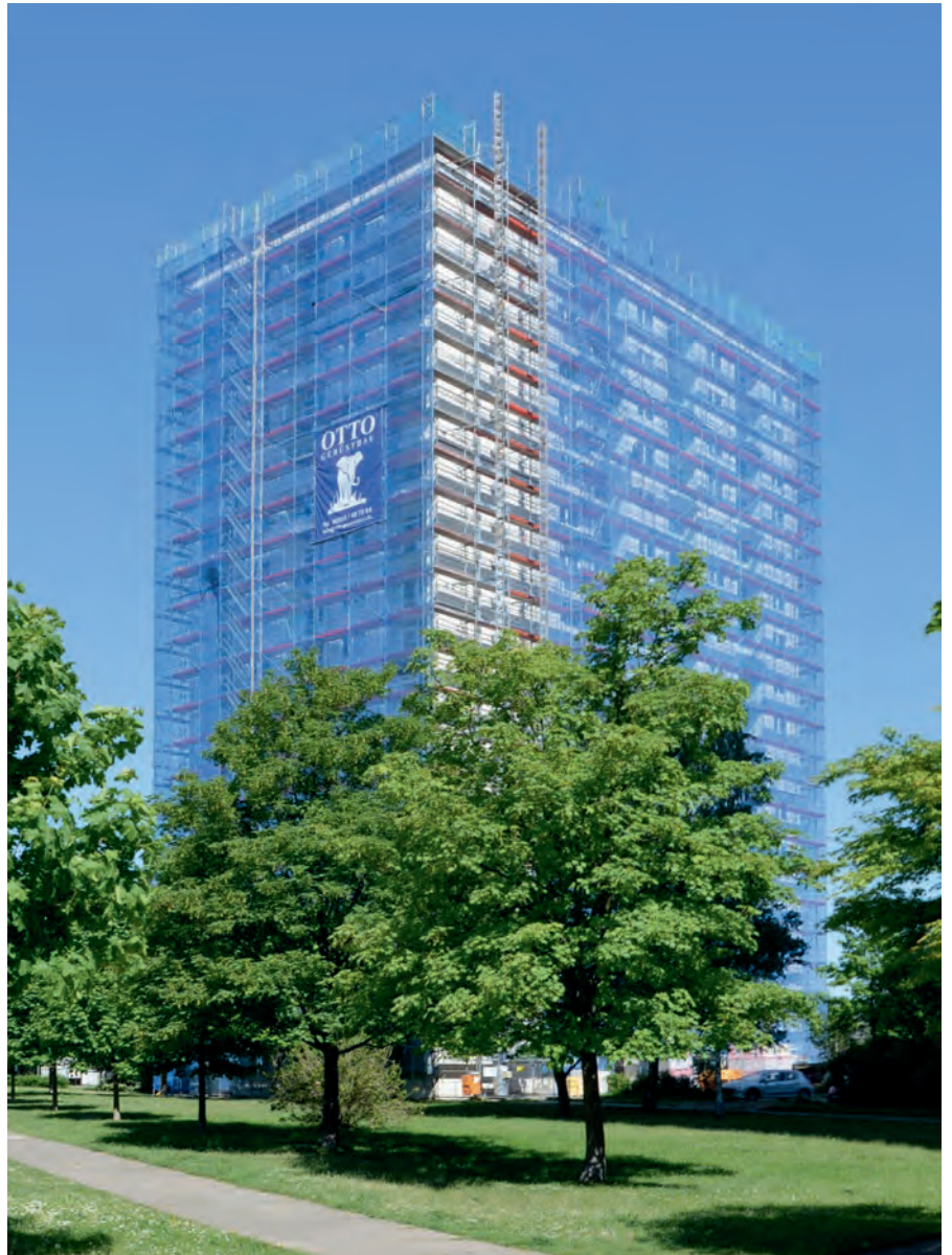
Das komplett eingerüstete Gebäude in Großschachwitz, Rathener Straße 115.
