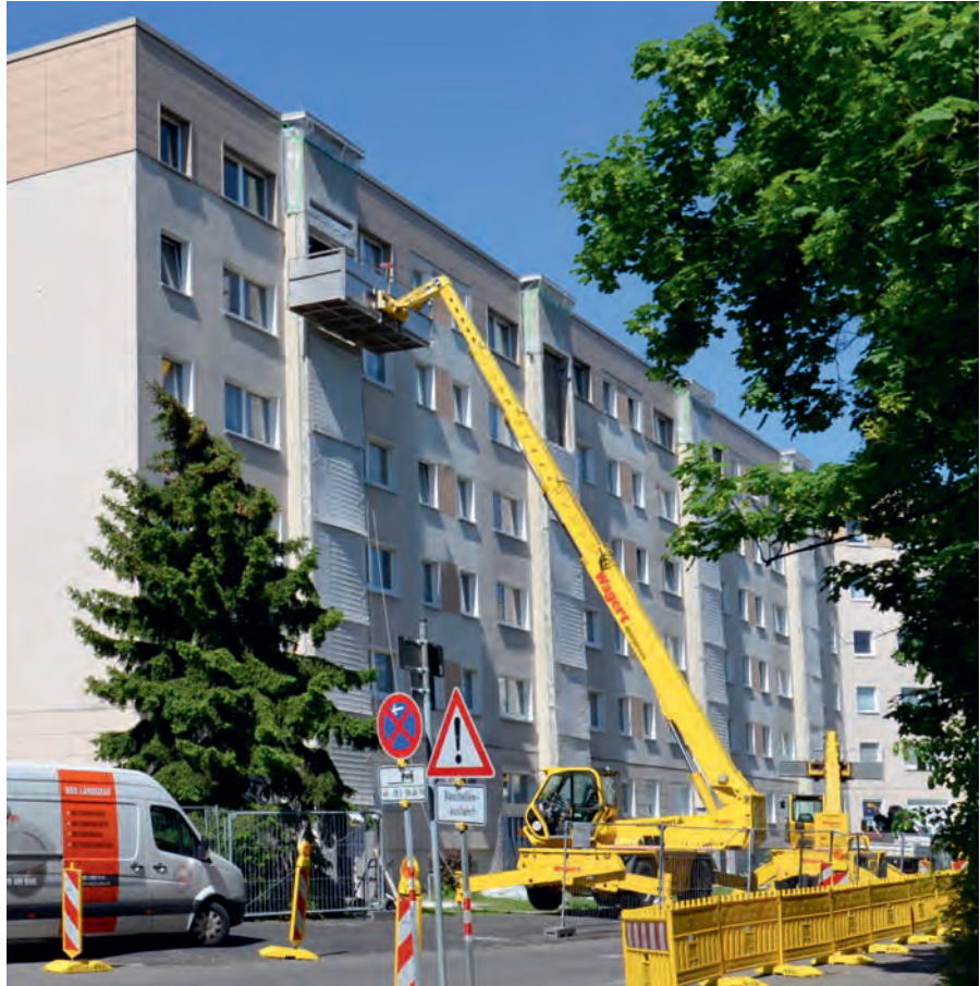
In der Schöner Straße 26–32 werden Außenaufzüge angebaut.
