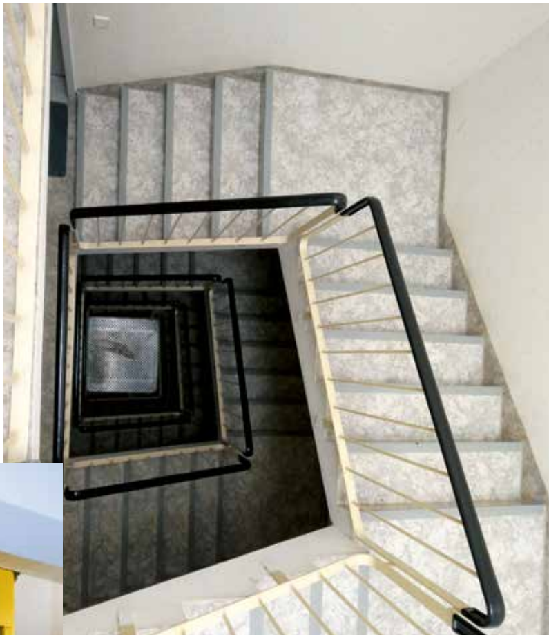
Das typische Treppenaug von oben gesehen: Hier bietet sich der Platz an, um moderne Aufzüge einzubauen, ähnlich dem Foto links.
