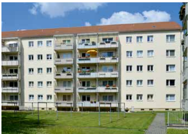
Lauensteiner Straße 49 – 55 nach der Sanierung, Hofansicht
