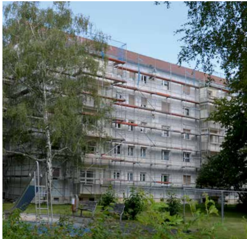
An der Eibenstocker Straße 78 – 84 wird das Wärmedämmverbundsystem nachverdübelt und der Oberputz erneuert.
