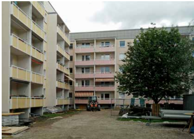
Der Innenhof während der Sanierungsphase.
