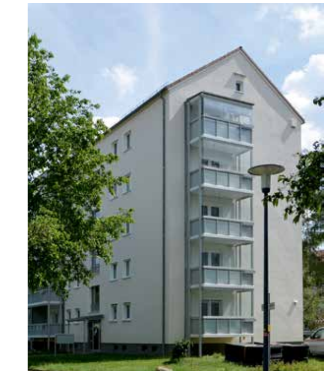
Lauensteiner Straße 39 – 47 nach der Sanierung
