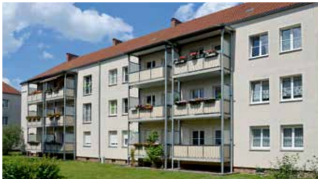
Prof.-Ricker-Straße 1 a – c vor der Sanierung.
